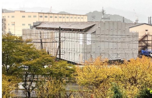
第二砲術科兵器庫／鉄骨造一部木造二階建
