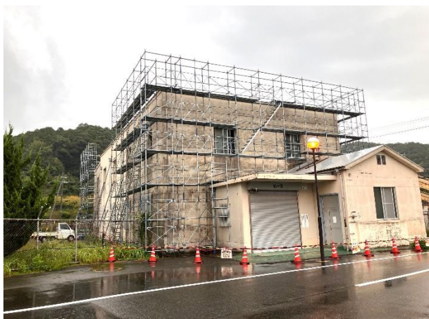
光学兵器庫／鉄筋コンクリート造二階建
