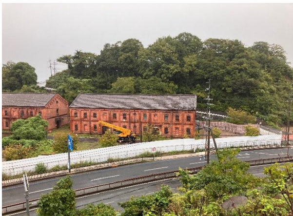
6号棟周辺の工事の様子
