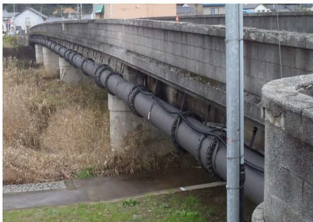
（伊佐津川・相生橋下流側にあったCIPφ550 海軍管）
