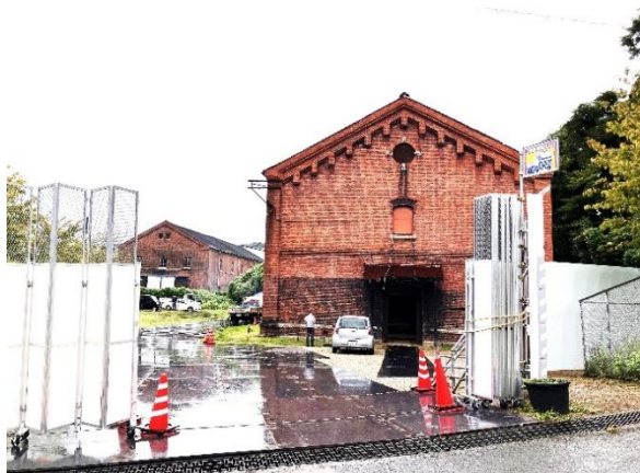
6号棟の工事現場の出入口
