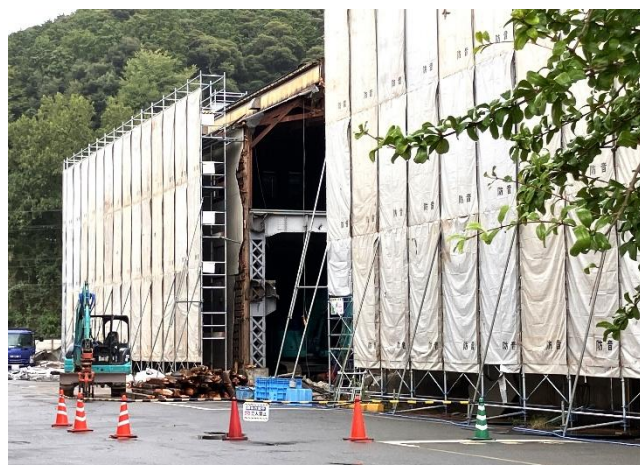
第二砲術科兵器庫解体の様子
