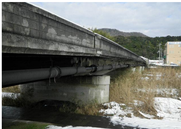
（相生橋上流側に架かっていたCIPφ300 町水道管）
