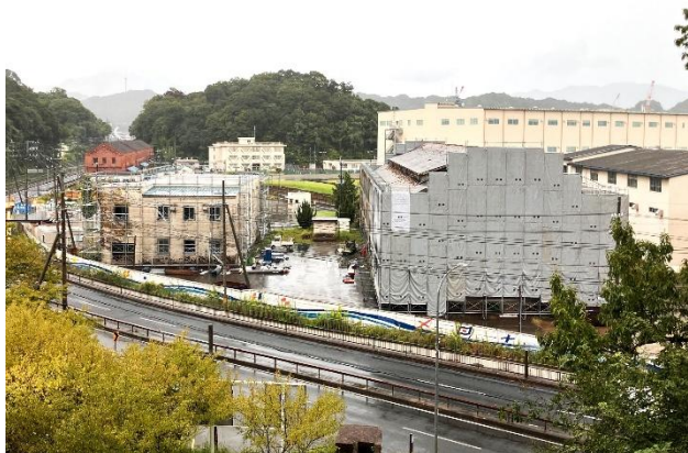
防衛省「三角地」2棟の建物解体工事の様子
