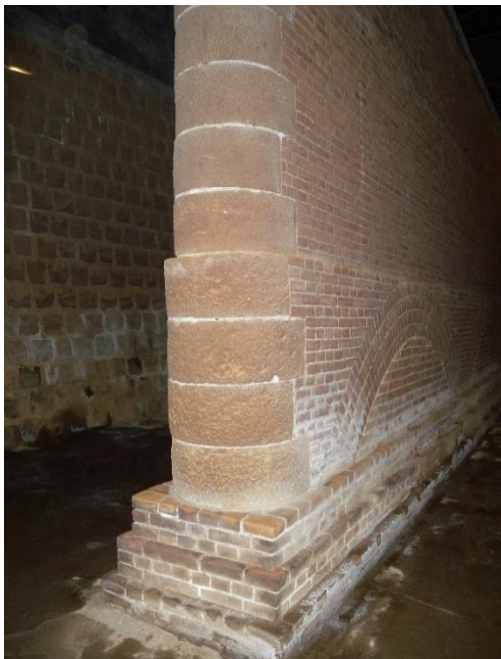
（北吸1号配水池の煉瓦積導流壁）
