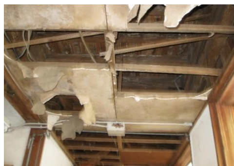
(2013.12.7 校舎一階廊下天井の様子)
