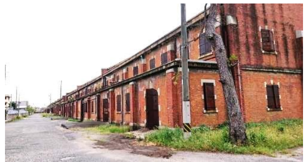
旧陸軍広島被服支廠倉庫 (広島県HP)
