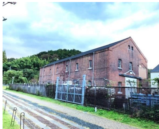
北吸三角地の17号倉庫
