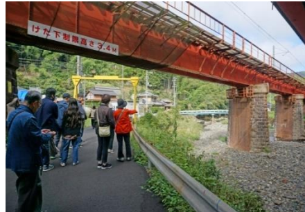
舞鶴市真倉第四伊佐津川橋梁
