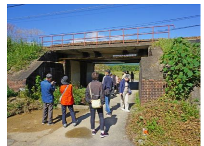
福知山市土師淵溝橋梁
