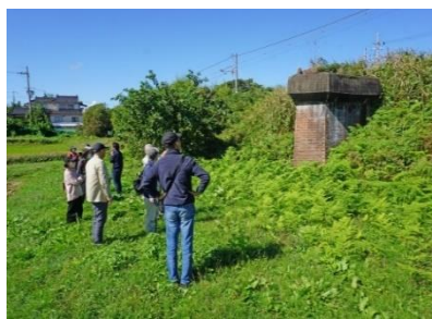
綾部市川糸町旧下由良川橋梁橋脚
