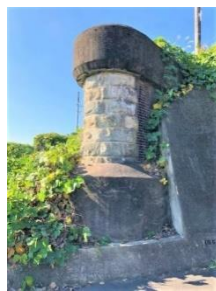
写真29 旧土師川橋梁橋脚
