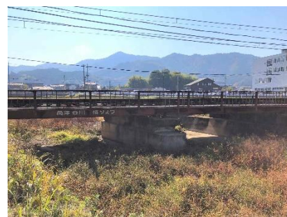
写真12 高津谷川橋梁
