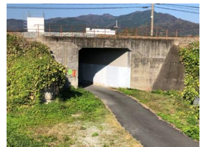
写真30 土師川東隧道
