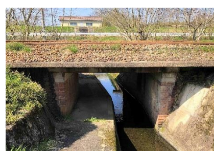
写真3 中筋大江橋梁
