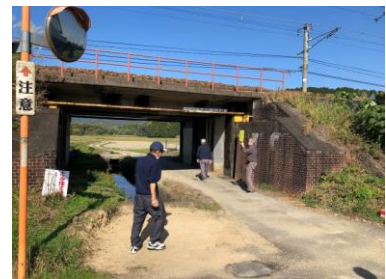
写真21 土師川東 3橋梁
