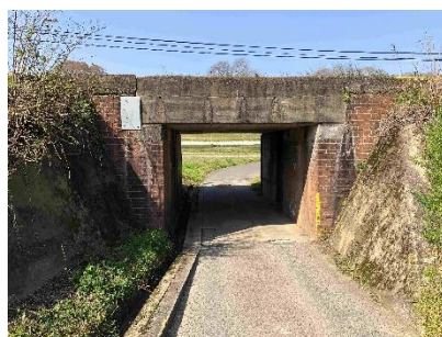
写真5 天田井橋梁の橋台
