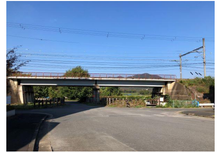
写真24 土師川東2橋梁
