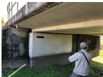
写真7 同橋梁下から
