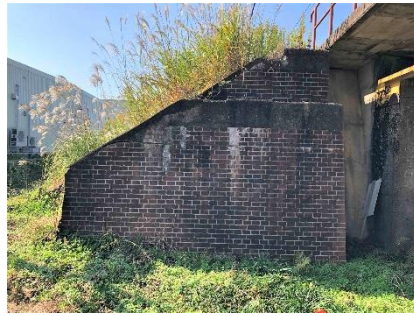
写真23 同旧橋台（西側）
