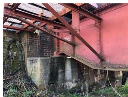
写真9 同 上り線の鉄桁
