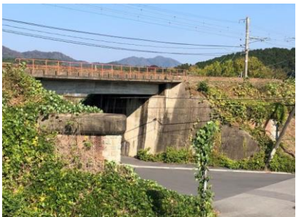
写真28 土師川東1橋梁
