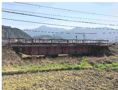
写真8 高津フケ溝橋梁
