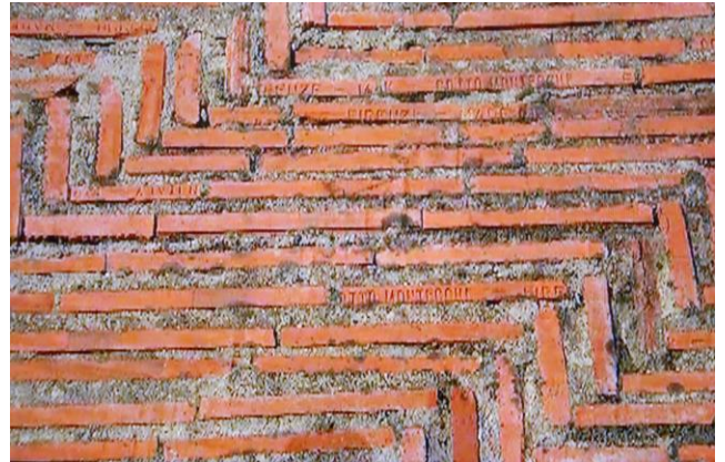
ドーム構造模型の細部(煉瓦の矢筈積みの部分)
