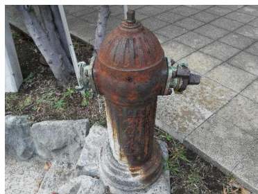
画像②消火栓の刻印
