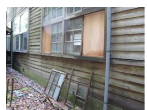
7/24 窓ガラスおよび窓枠欠損箇所 ベニヤ板で仮修理
